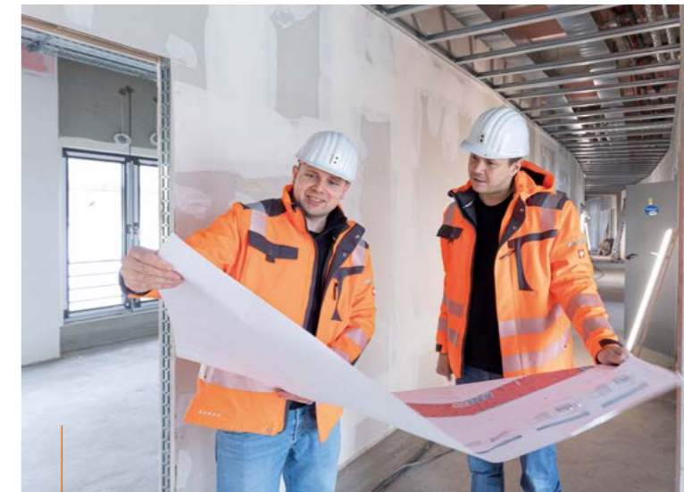
Endlager Morsleben: Rohbau des neuen Verwaltungsgebäudes. Konstantin Bochmann und Marcus Eggstein schauen sich die weiteren Planungen für den Innenausbau an.
