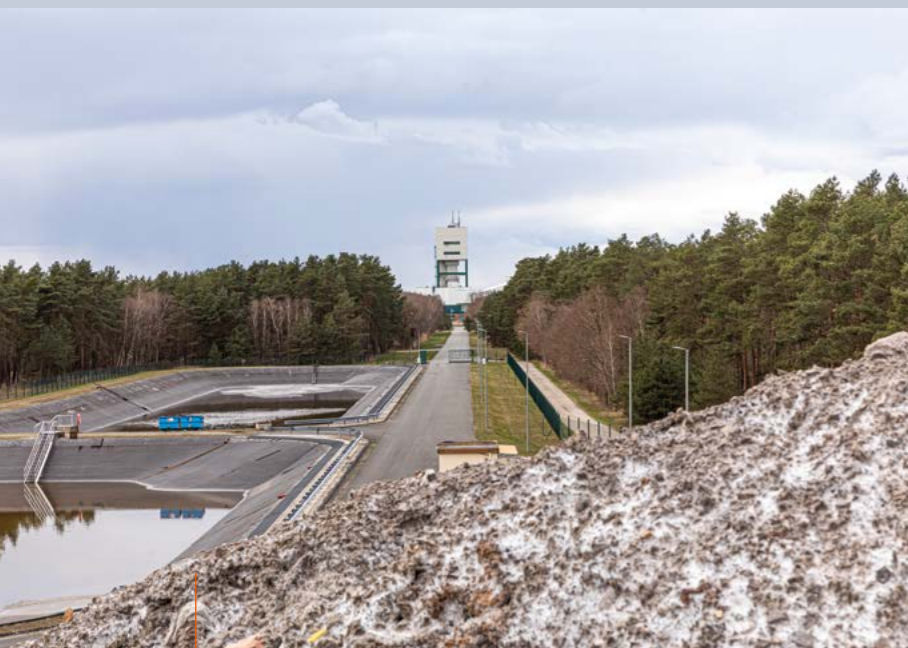
Bergwerk Gorleben: Der Rückbau hat begonnen
