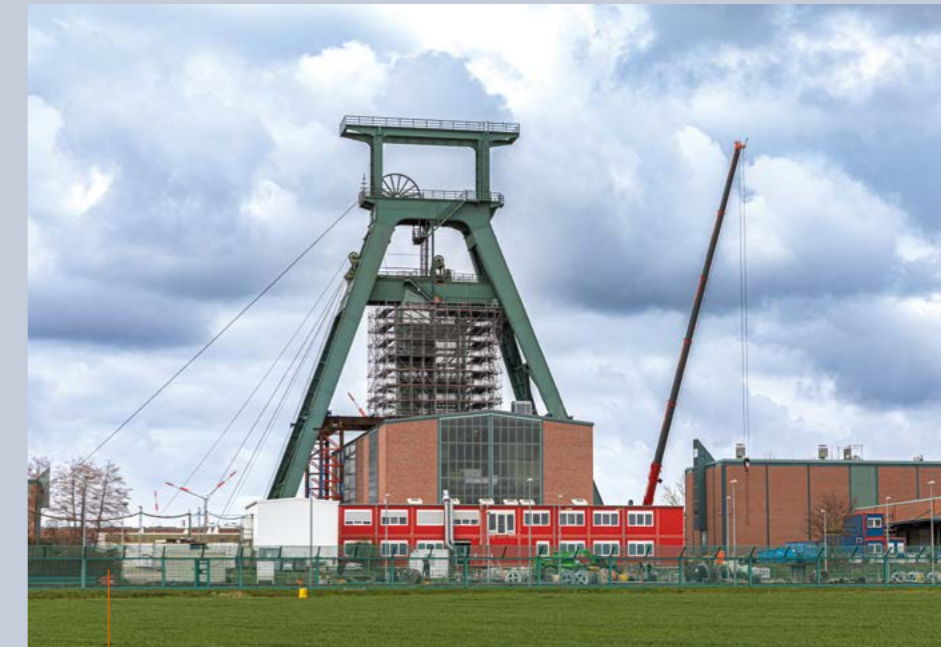
Schachanlage Konrad: Vorbereitung auf den Führungsgerüstwechsel
