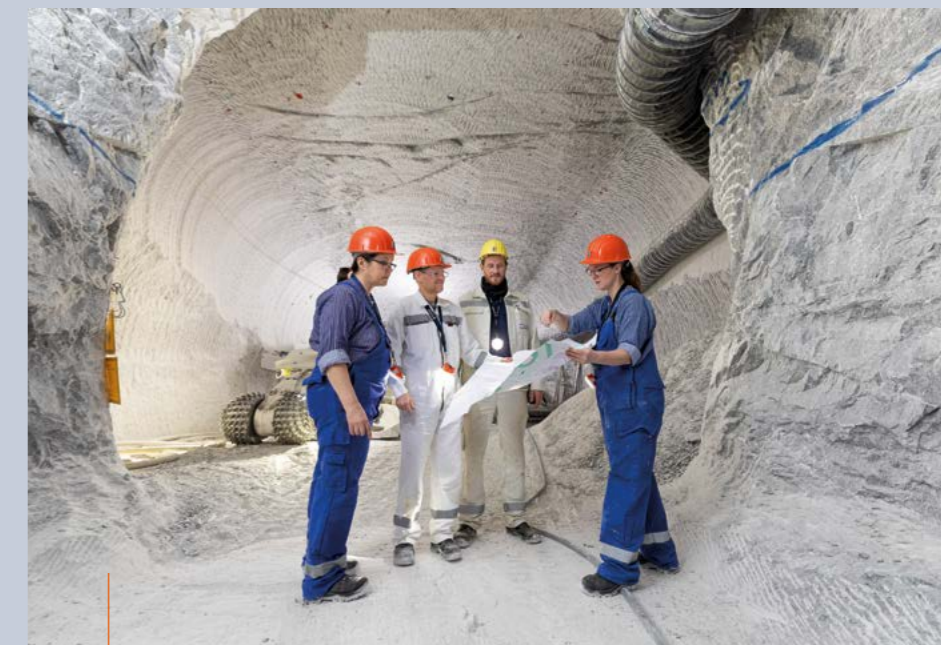
Endlager Morsleben: Demonstrationsbauwerk im Hauptanhydrit
